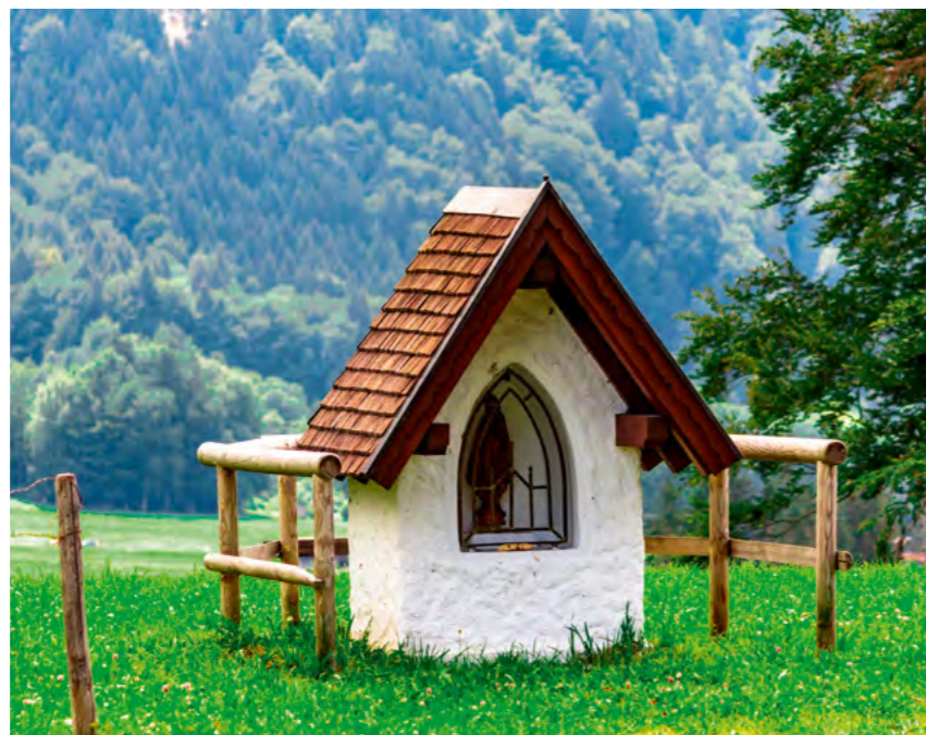
Manchmal sind an unscheinbaren Orten Geschichten des Lebens und Glaubens verborgen, die für Menschen neu entdeckt, renoviert und erschlossen werden können.
